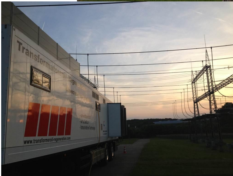
Fig. 3 & 4 : Installation de régénération MRA 4x4 dans le poste de transformation Linde de la société Amprion GmbH
